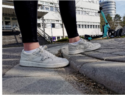
Bordsteinhöhe 3cm ohne taktil erstastbaren Bodenindikatoren
