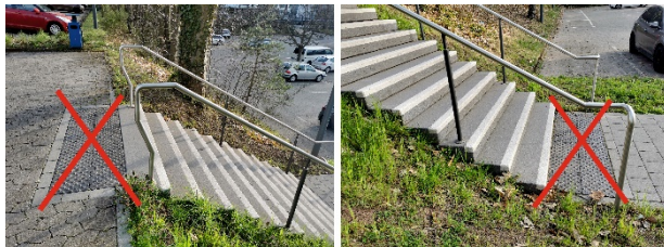
keine taktilen Felder vor einer abwärts- und aufwärtsführenden Treppe
