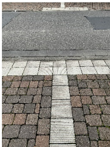
Nullabsenkung (Bordstein auf Höhe der Fahrbahn) mit taktil erstastbaren Bodenindikatoren und Auffindestreifen
