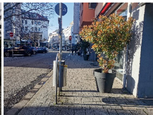
Unterbrochene Leitlinie (Häuserwand) durch Blumentopf und Mülleimer
