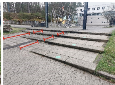
Tiefe der Stufen bleibt nicht gleich
