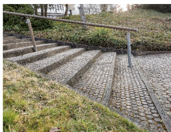
Handlauf endet mit letzter Stufe, keine Weiterführung um 30cm
