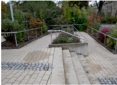
Beispiel einer barrierefreien Rampe
