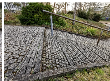
Handlauf endet mit letzter Stufe, keine Weiterführung um 30cm
