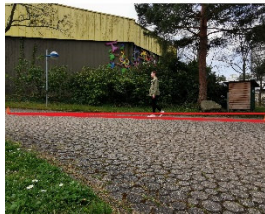
Steigung/Gefälle 3%, Länge 10m
