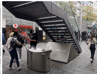
abgesicherte unterlaufbare Treppe
