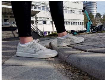
Bordsteinhöhe 3cm ohne visuell kontrastreichen Bodenindikatoren
